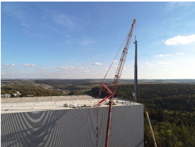
Bild 1+2: Einbringung Regalbediengeräte.jpg
